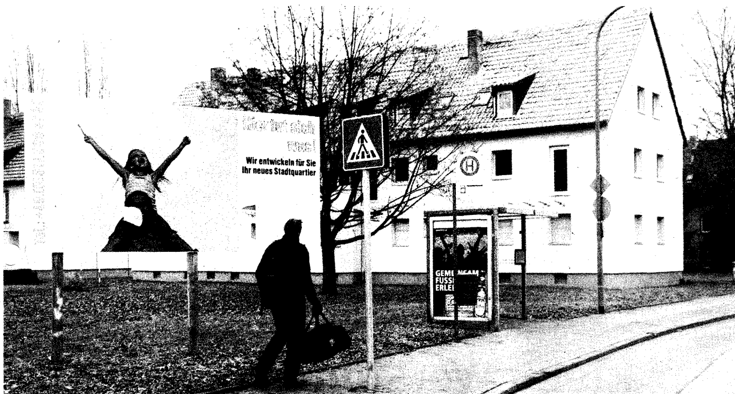
Nach einer witterungsbedingten Pause soll die Sanierung der 172 Wohnungen am Kinzigheimer Weg in den nächsten Tagen fortgesetzt werden. Foto: Paul
