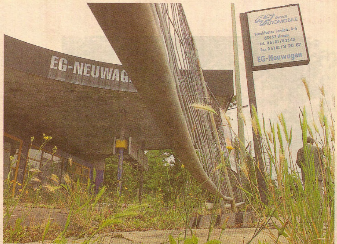
Unkraut wuchert auf dem verlassenen Tankstellen-Areal an der Kinzigbrücke.
